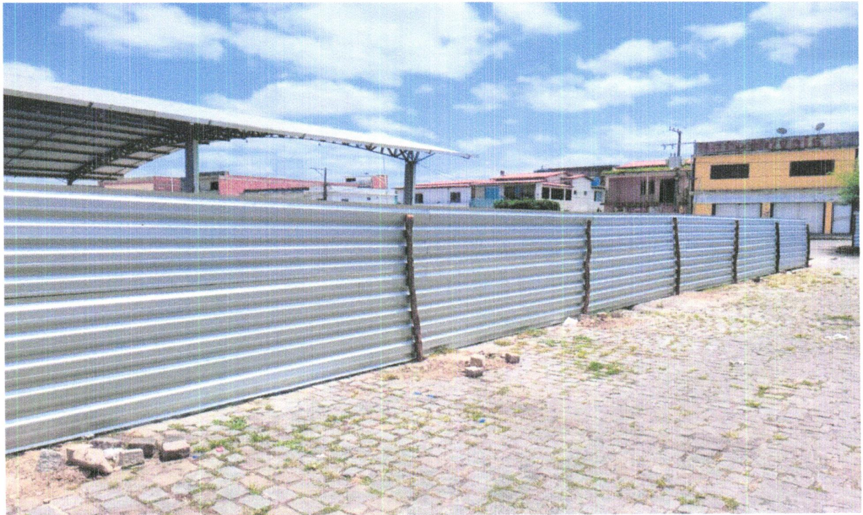
FOTO 08 - TAPUME COM TELHA METÁLICA. AF_05/2018
