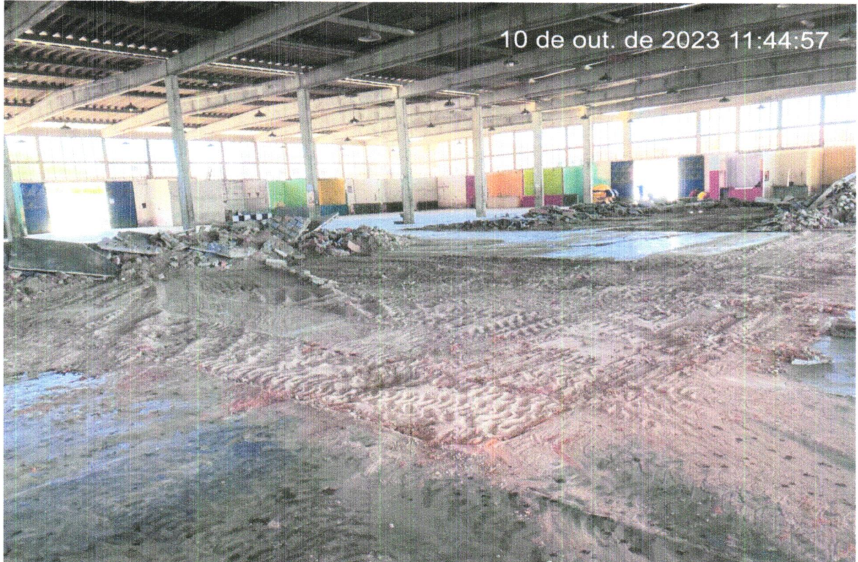
FOTO 26 - DEMOLIÇÃO MANUAL DE PISO CIMENTADO SOBRE LASTRO DE CONCRETO - REV 01
