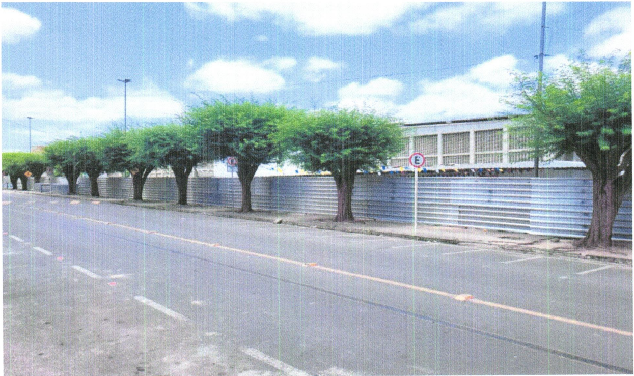
FOTO 04 - TAPUME COM TELHA METÁLICA. AF_05/2018
