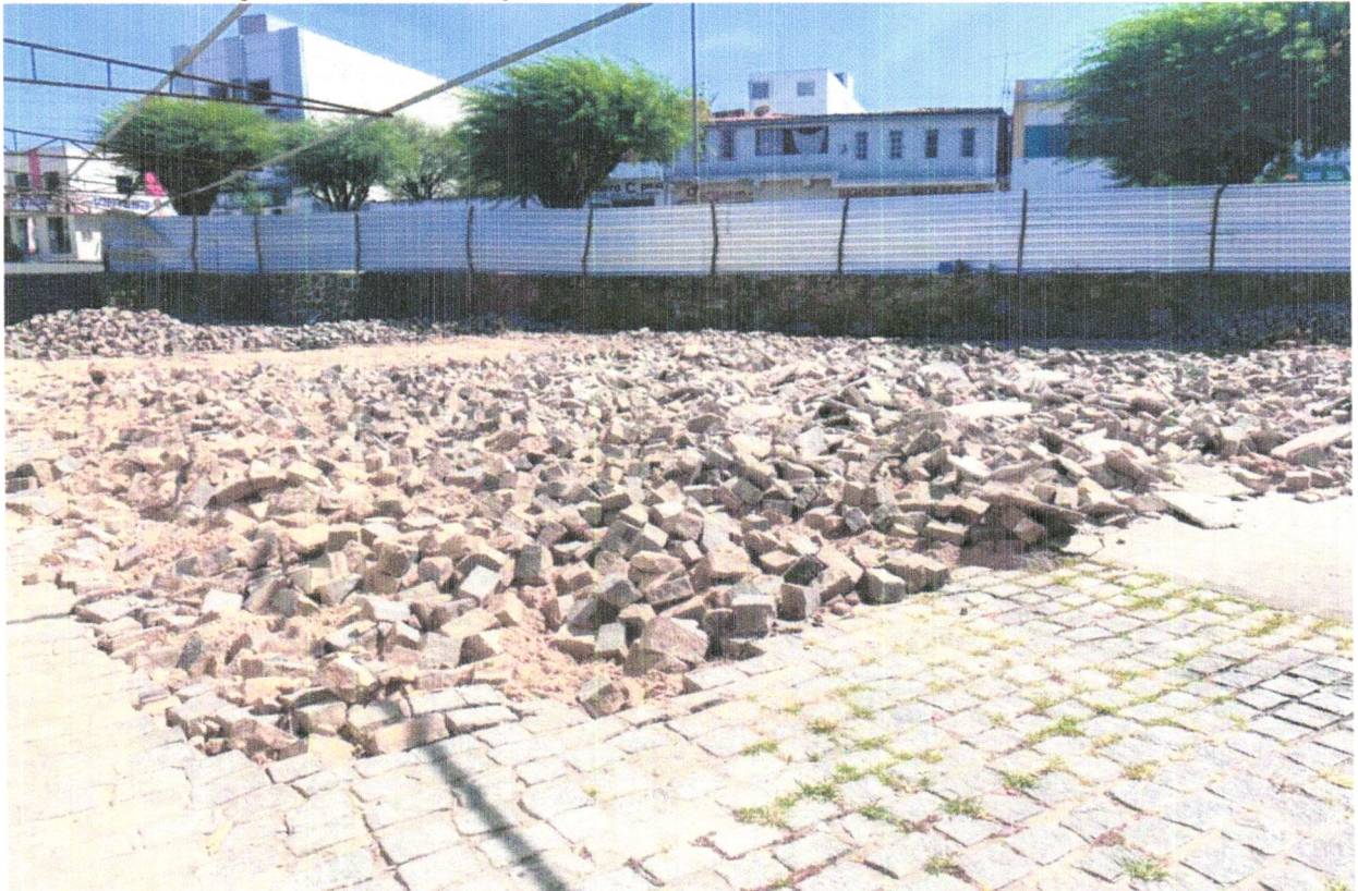
FOTO 18 - DEMOLIÇÃO DE PAVIMENTAÇÃO EM PARALELEPÍPEDO SEM REAPROVEITAMENTO
