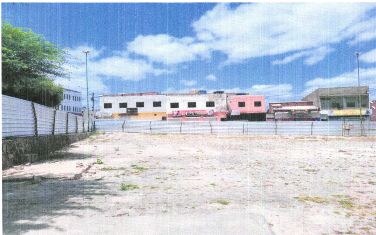
FOTO 12 - TAPUME COM TELHA METÁLICA. AF_05/2018
