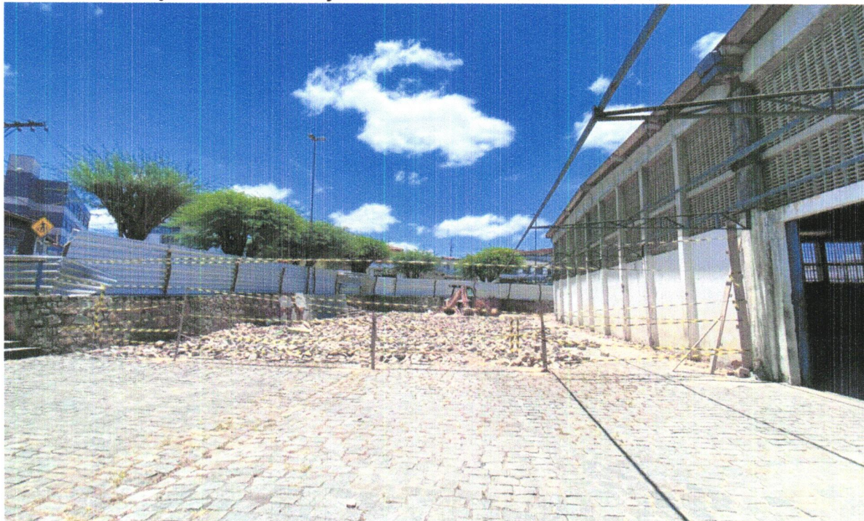
FOTO 16 - DEMOLIÇÃO DE PAVIMENTAÇÃO EM PARALELEPÍPEDO SEM REAPROVEITAMENTO
