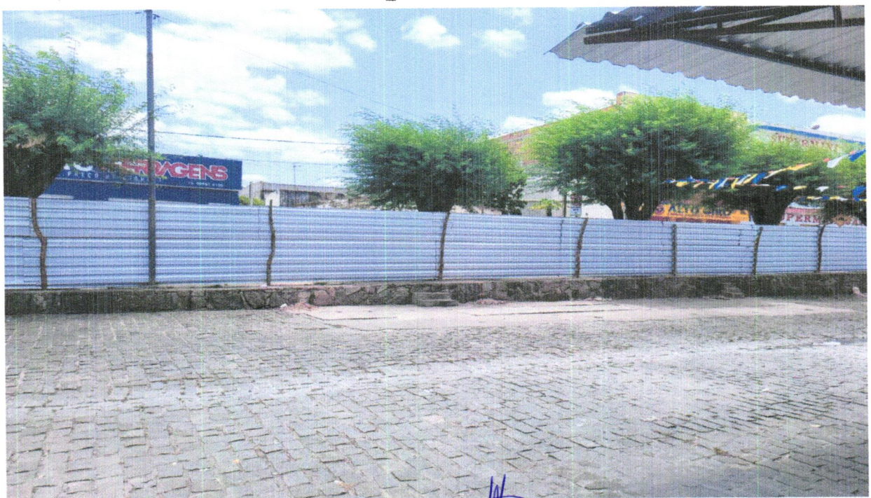
FOTO 08 - TAPUME COM TELHA METÁLICA. AF_05/2018
