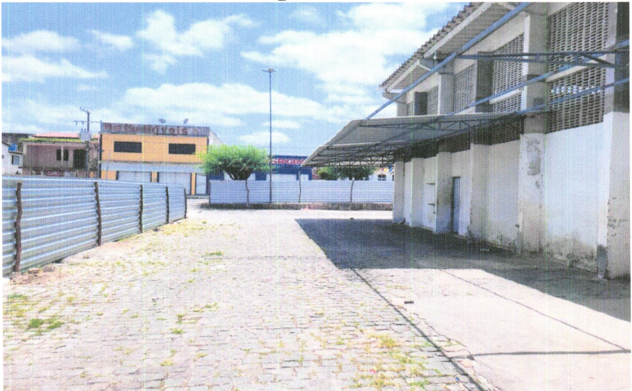
FOTO 06 - TAPUME COM TELHA METÁLICA. AF_05/2018
