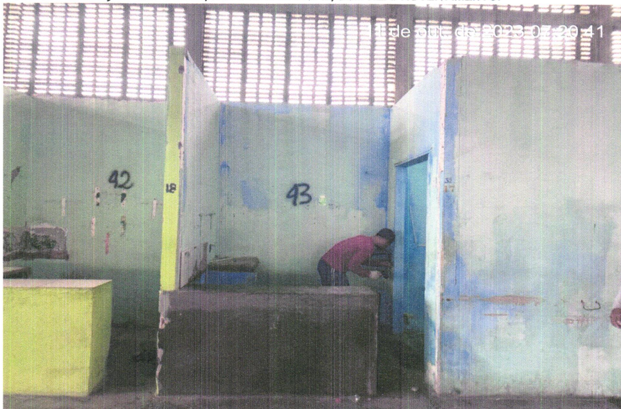
FOTO 32 - REMOÇÃO DE PORTAS, DE FORMA MANUAL, SEM REAPROVEITAMENTO.
