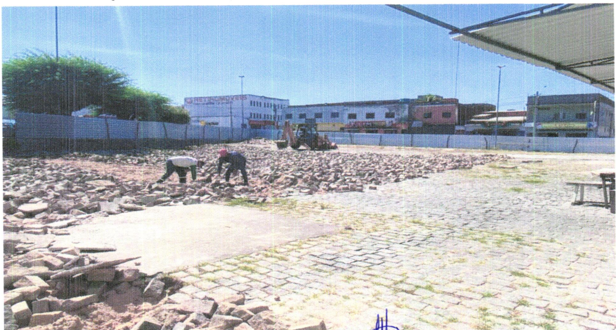
FOTO 18 - DEMOLIÇÃO DE PAVIMENTAÇÃO EM PARALELEPÍPEDO SEM REAPROVEITAMENTO
