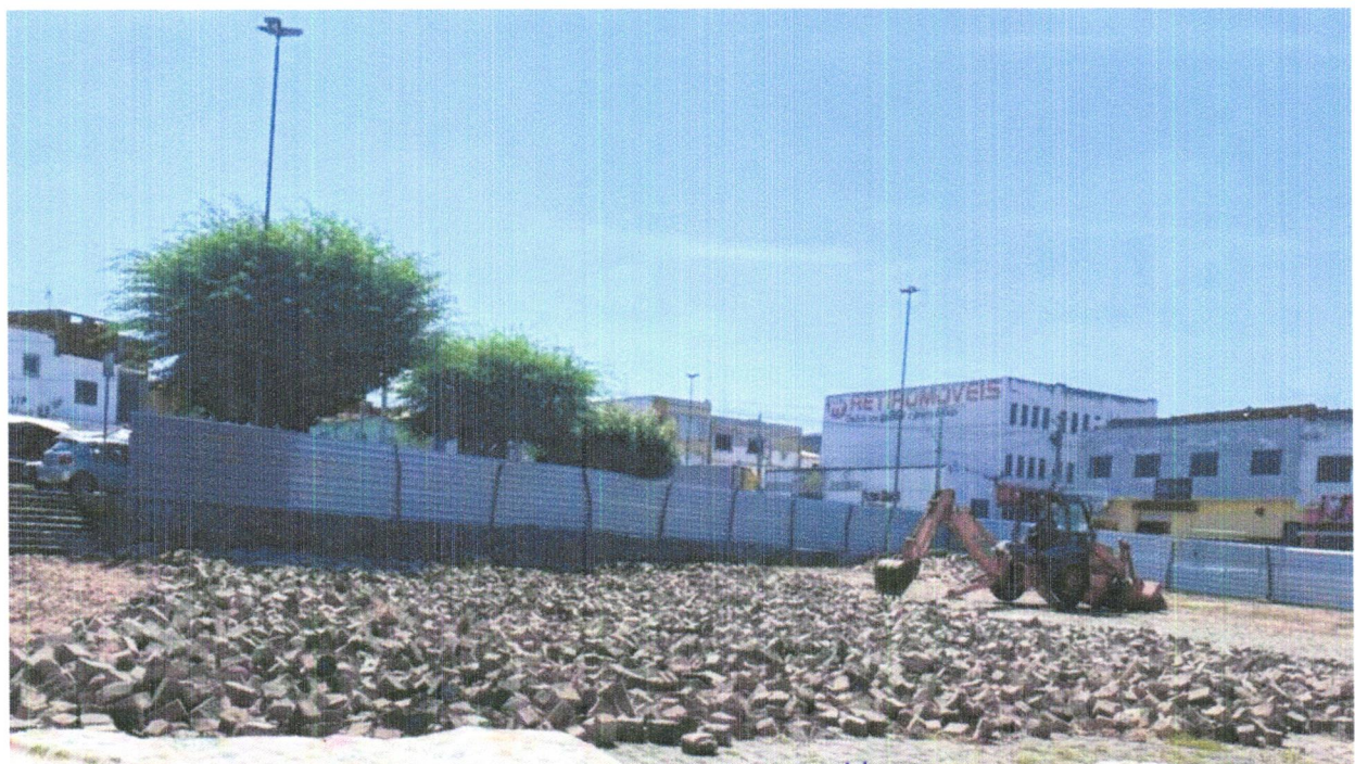
FOTO 20 - DEMOLIÇÃO DE PAVIMENTAÇÃO EM PARALELEPÍPEDO SEM REAPROVEITAMENTO
