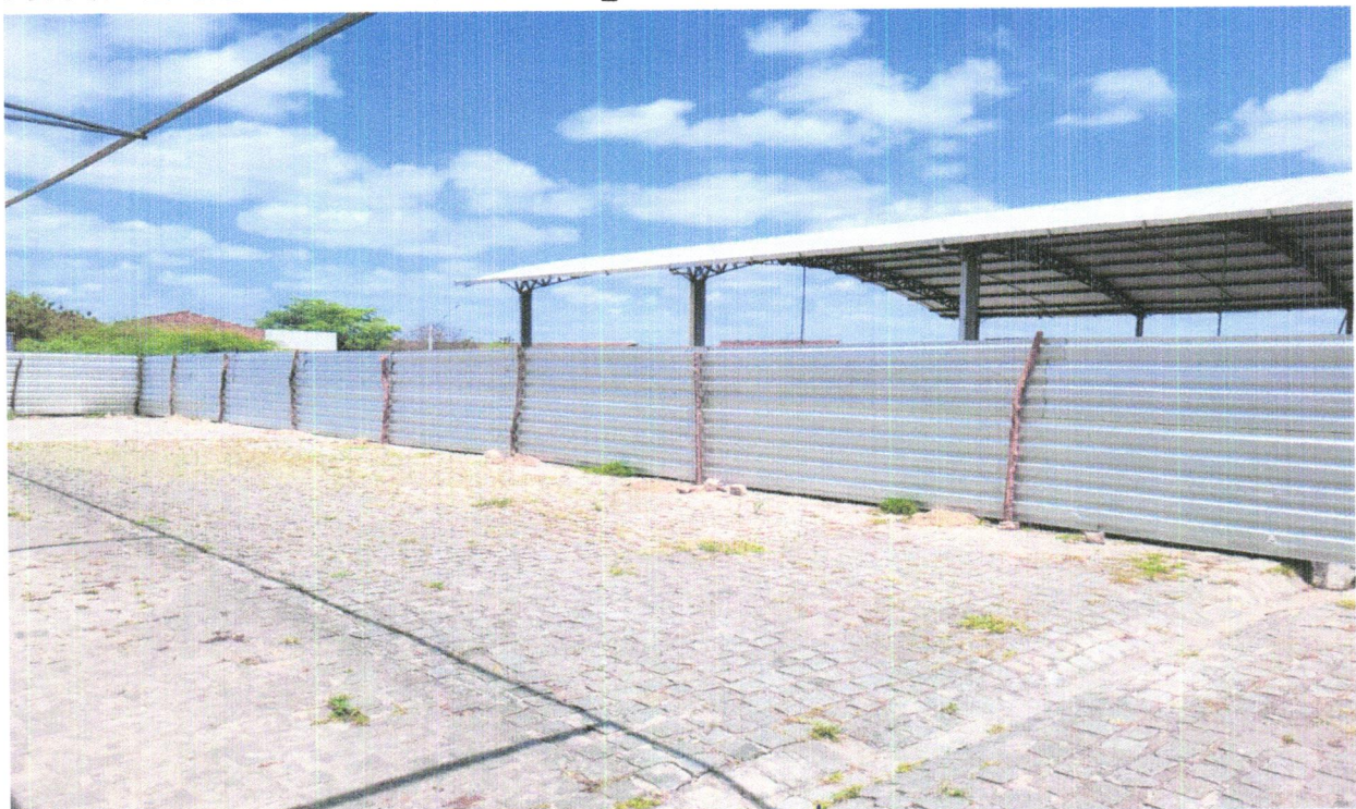
FOTO 06 - TAPUME COM TELHA METÁLICA. AF_05/2018
