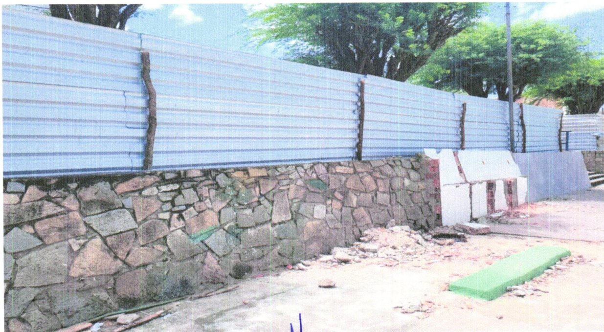
FOTO 12 - TAPUME COM TELHA METÁLICA. AF_05/2018
