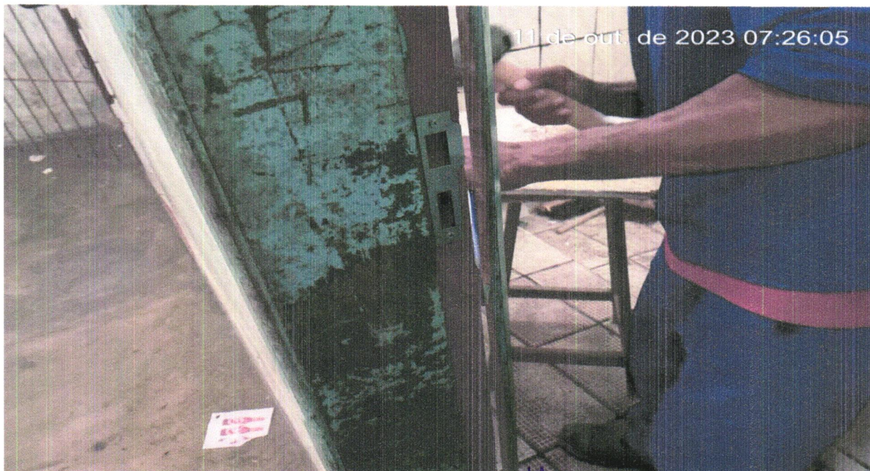
FOTO 32 - REMOÇÃO DE PORTAS, DE FORMA MANUAL, SEM REAPROVEITAMENTO.
