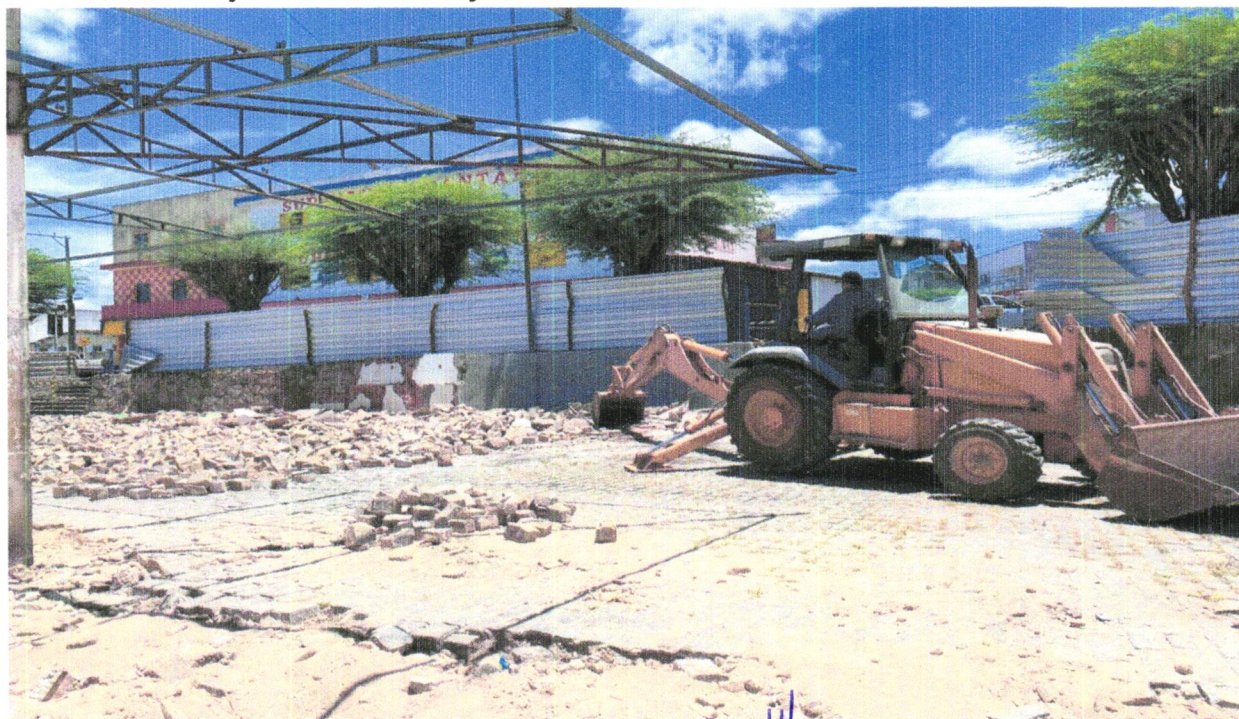
FOTO 16 - DEMOLIÇÃO DE PAVIMENTAÇÃO EM PARALELEPÍPEDO SEM REAPROVEITAMENTO
