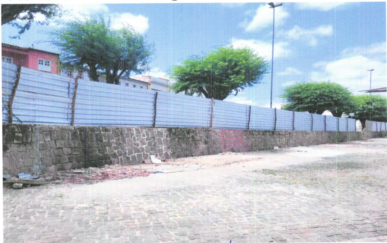
FOTO 04 - TAPUME COM TELHA METÁLICA. AF_05/2018
