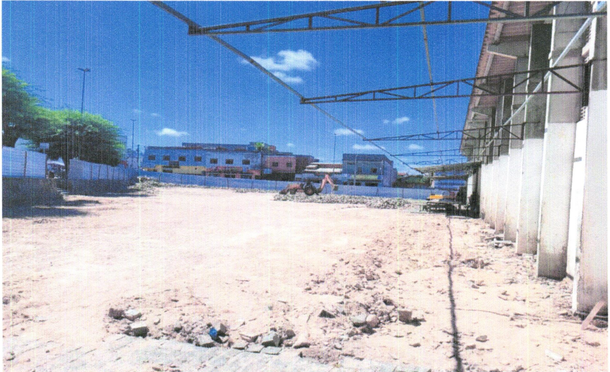
FOTO 20 - DEMOLIÇÃO DE PAVIMENTAÇÃO EM PARALELEPÍPEDO SEM REAPROVEITAMENTO
